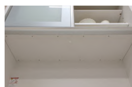
湿気を自在に調節し、有害物質を吸収、消臭効果もある不燃材、*MOISSをカウンター天板上に使用
